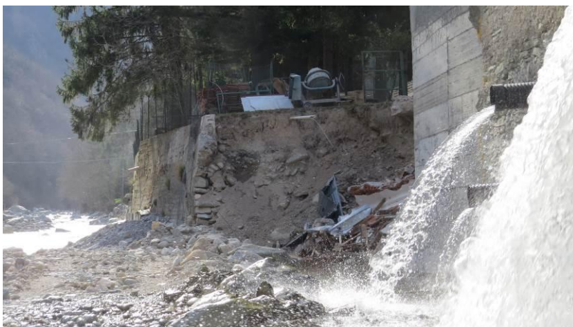
Foto n° 3: intervento località Le Trou; a tergo dei muri crollati sono presenti anche terreni di riporto; in alveo sono visibili grossi blocchi; il substrato affiora più a valle in alveo.
