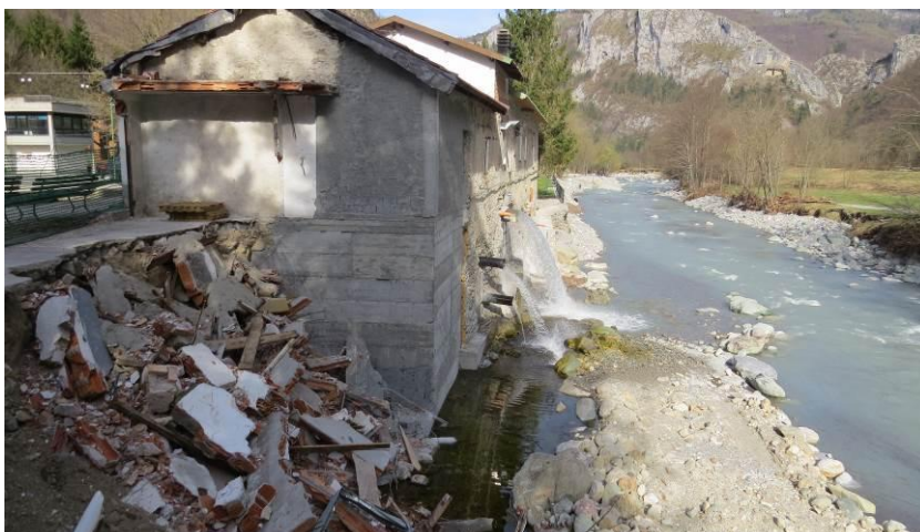
Foto n° 4: intervento località Le Trou (l'edificio distrutto dall'erosione)
