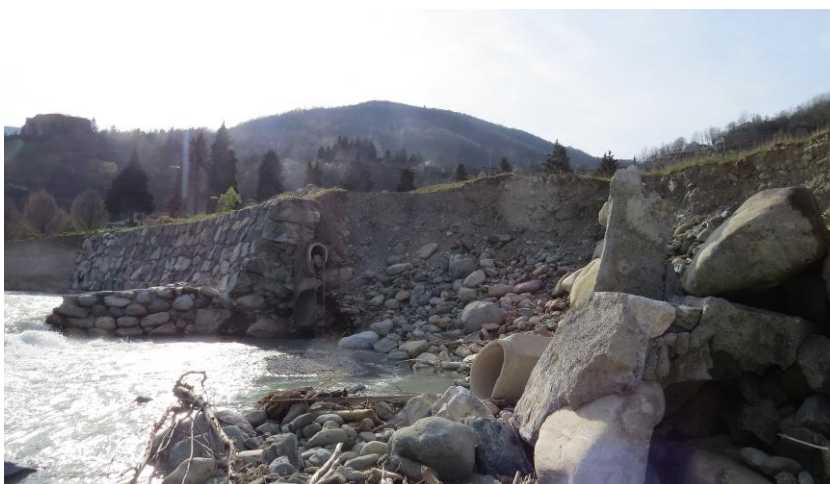
Foto n° 5: intervento località Cimitero (a tergo delle scogliere crollate sono presenti terreni di riporto e depositi alluvionali)
